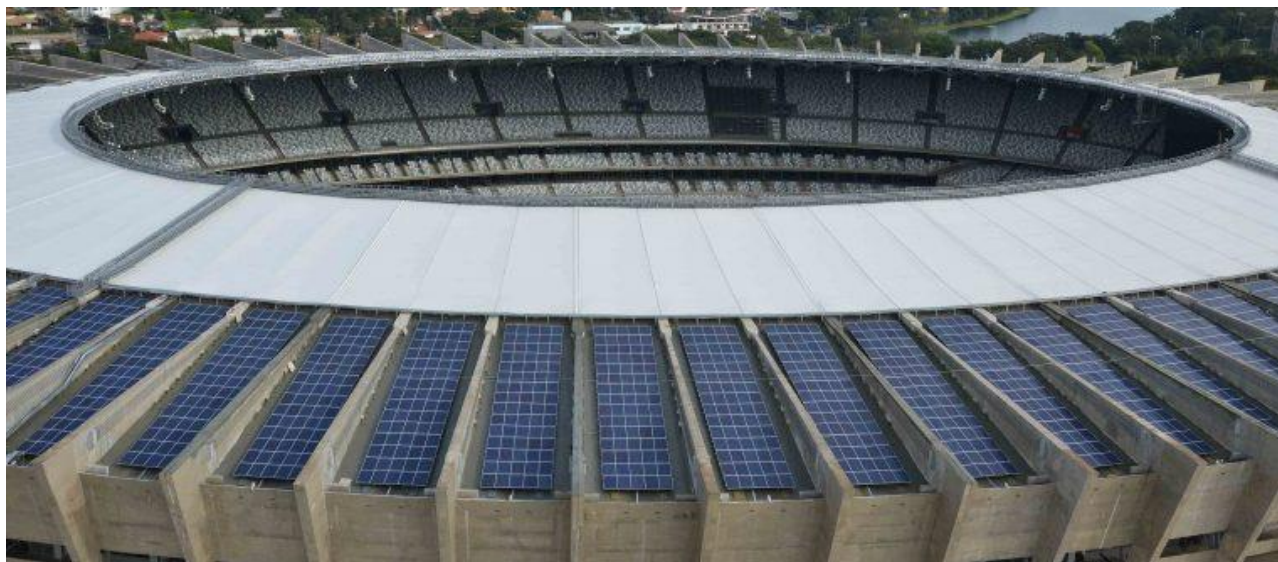
Figura 1 – Usina Fotovoltaica do estádio Mineirão.
