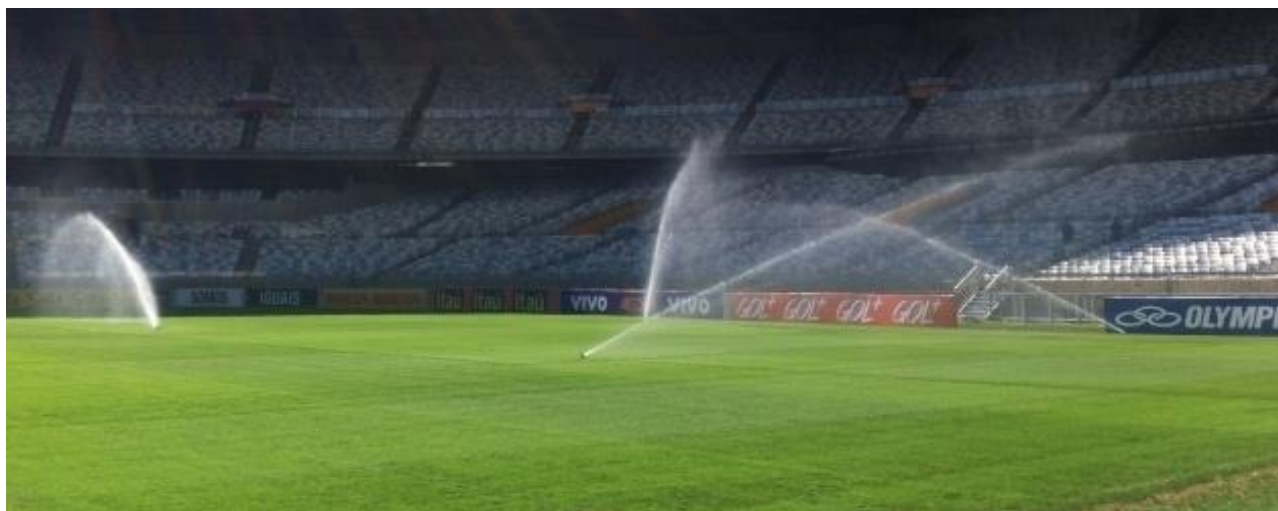
Figura 2 – Irrigação do gramado com água captada da chuva.
